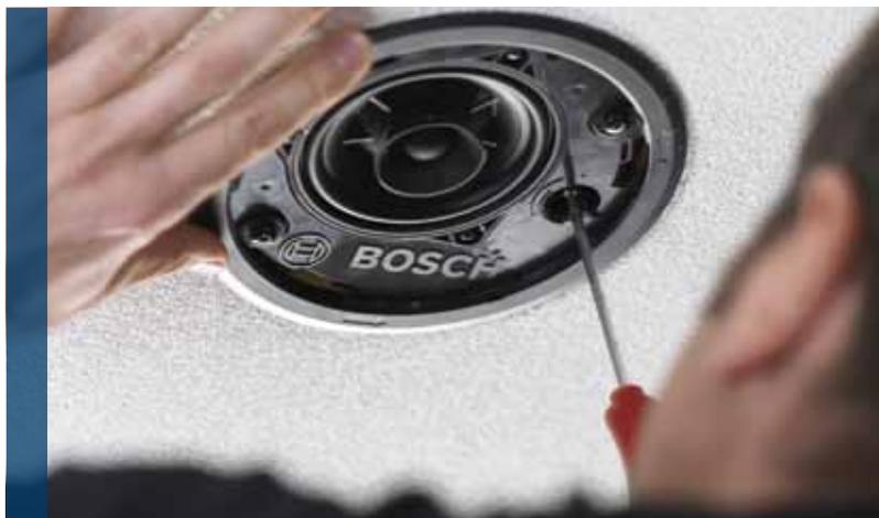
Le commutateur de raccordement permet de remplacer la sortie d'alimentation une fois le haut-parleur monté.
